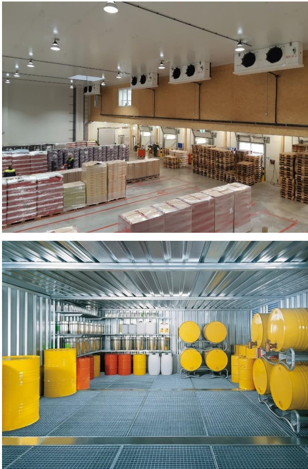
Abbildung 5: Kühllager [frischelogistic.com], Gefahrstofflager [fladafi.de]
